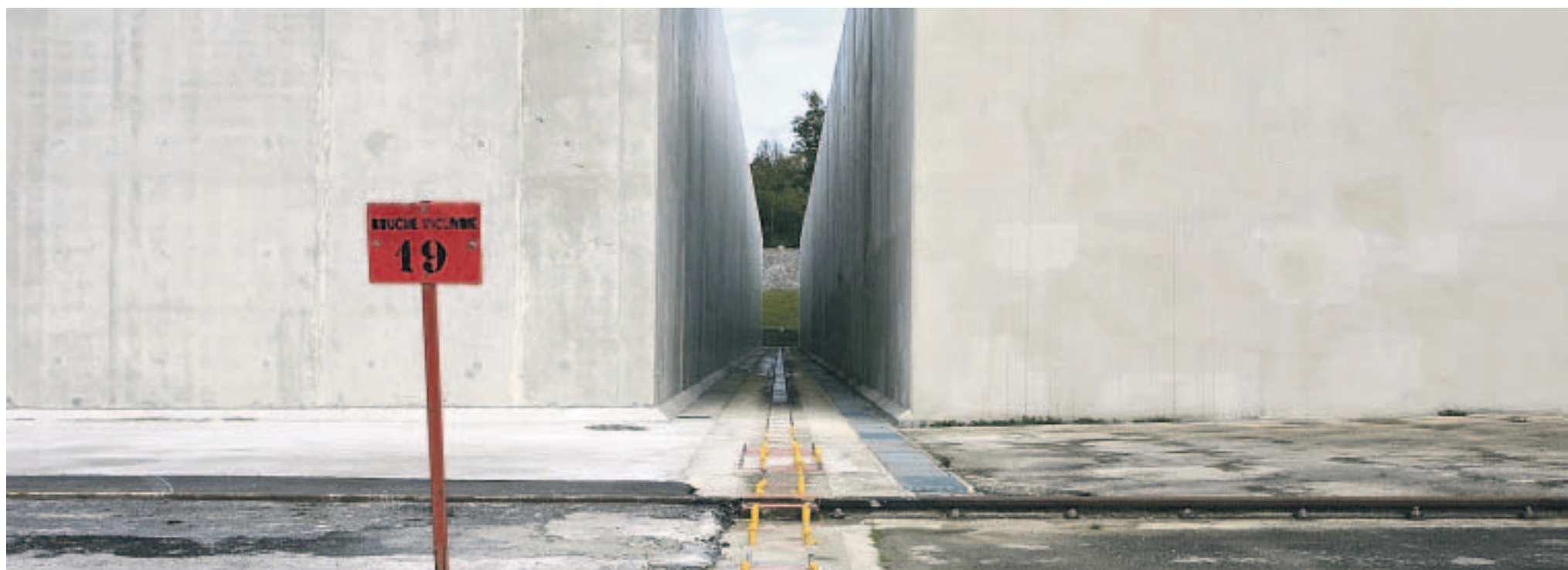
In solche Quader aus dicken Betonwänden wird der radioaktive Abfall im Endlager Soulaines eingelagert. Fast 300 Jahre wird er noch strahlen.
